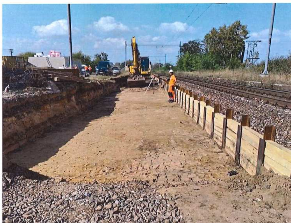
Odkop zeminy žel. spodku po zemnú pláň a úprava zemnej pláne - SO 11-32-02
