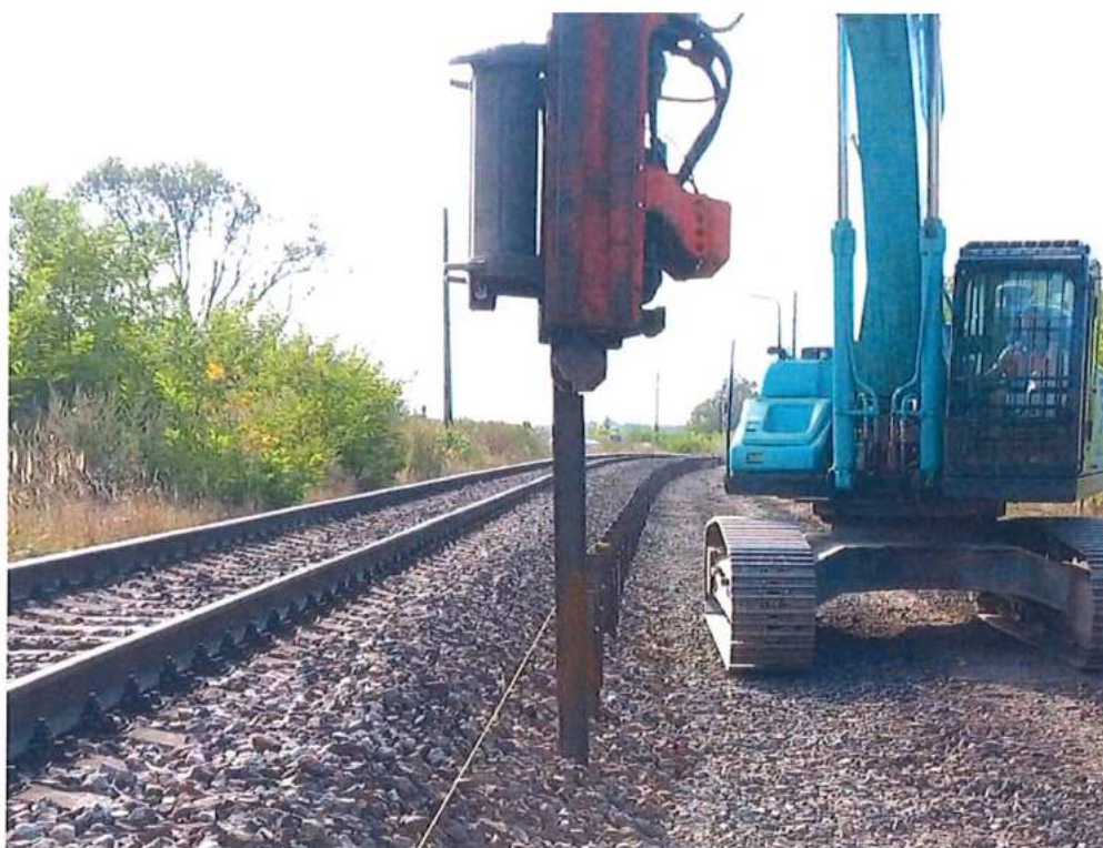
Baranenie zápor HEB v ose koľají - SO 11-32-02
