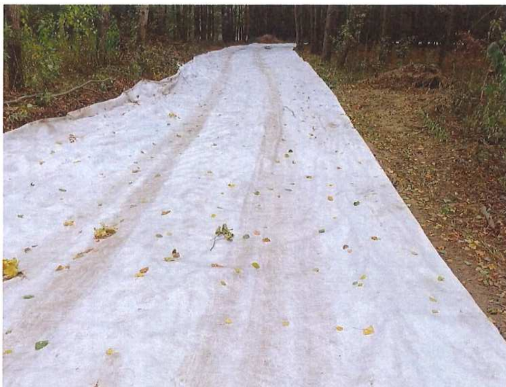
Pokládka geotextílie - Prístupové komunikácie na UČS 10
