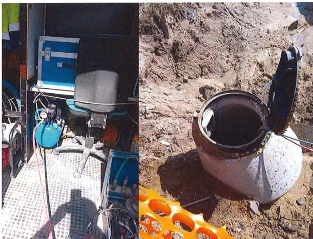
Tlaková skúška kanalizácie - SO 11-37-06.1
