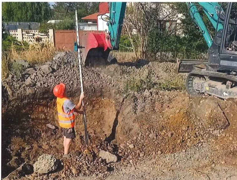
Zemné práce, výkop pre základovú dosku techn. kontajnera - SO 11-34-08
