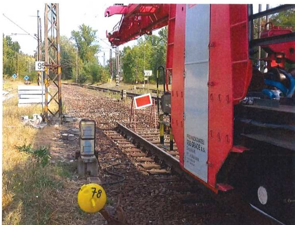
Ukončenie demontáže koľajových polí na UČS 10 (po začiatok výh.č.78) - SO 10-32-03
