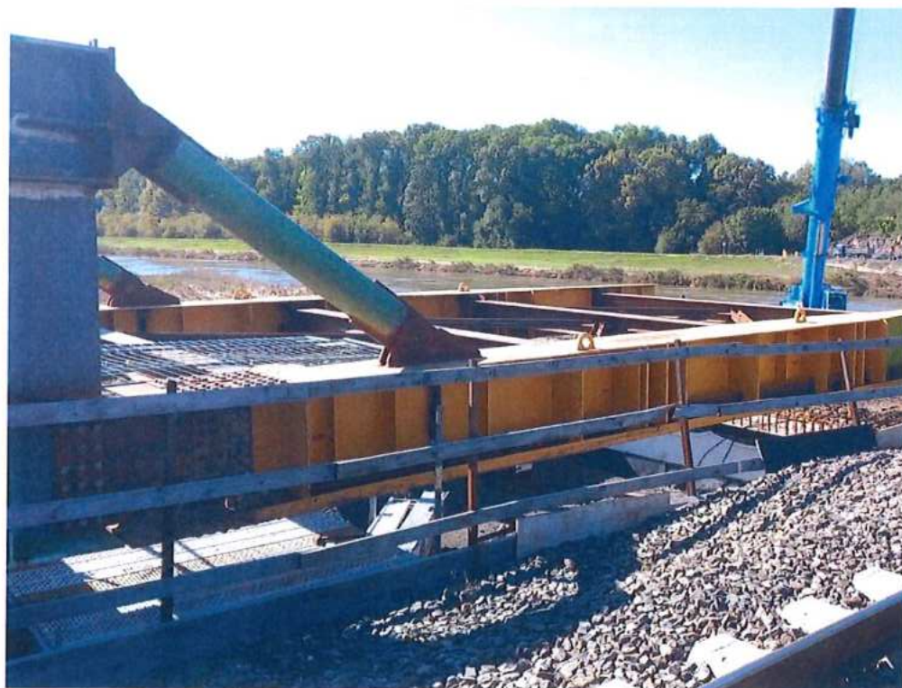
Montáž pomocných konštrukcií pre výsun - SO 12-33-04
