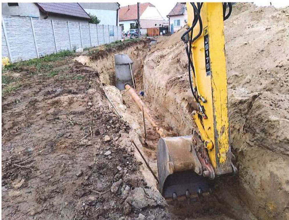
Preložka kanalizácie - SO 11-37-06.1
